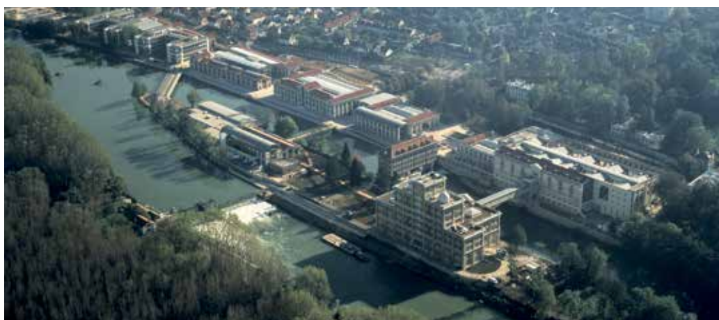
► Vue aérienne du site à Noisiel et Torcy
