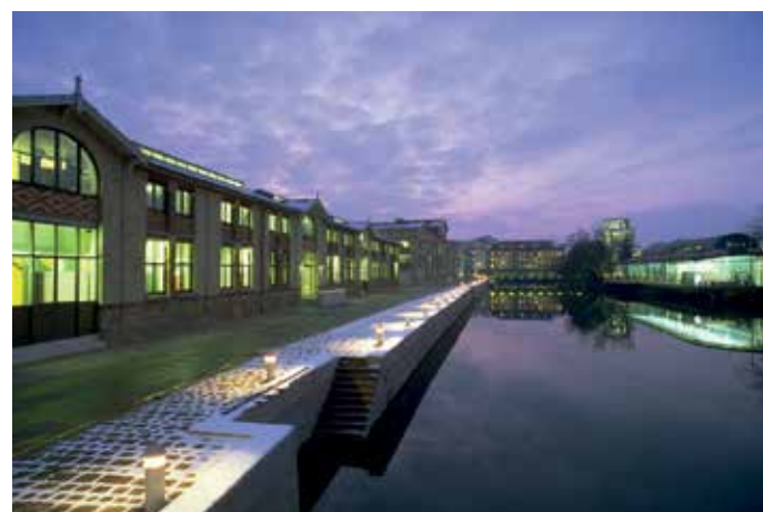
► Vue du site restauré en 1996 par l'agence d'architecture-urbaniste Reichen et Robert & Associés
